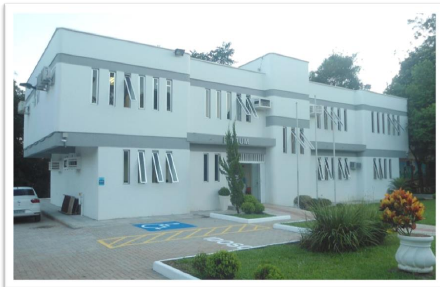
Reforma Fórum da Comarca de São Carlos – acessibilidade – Foto: Acervo DEA
