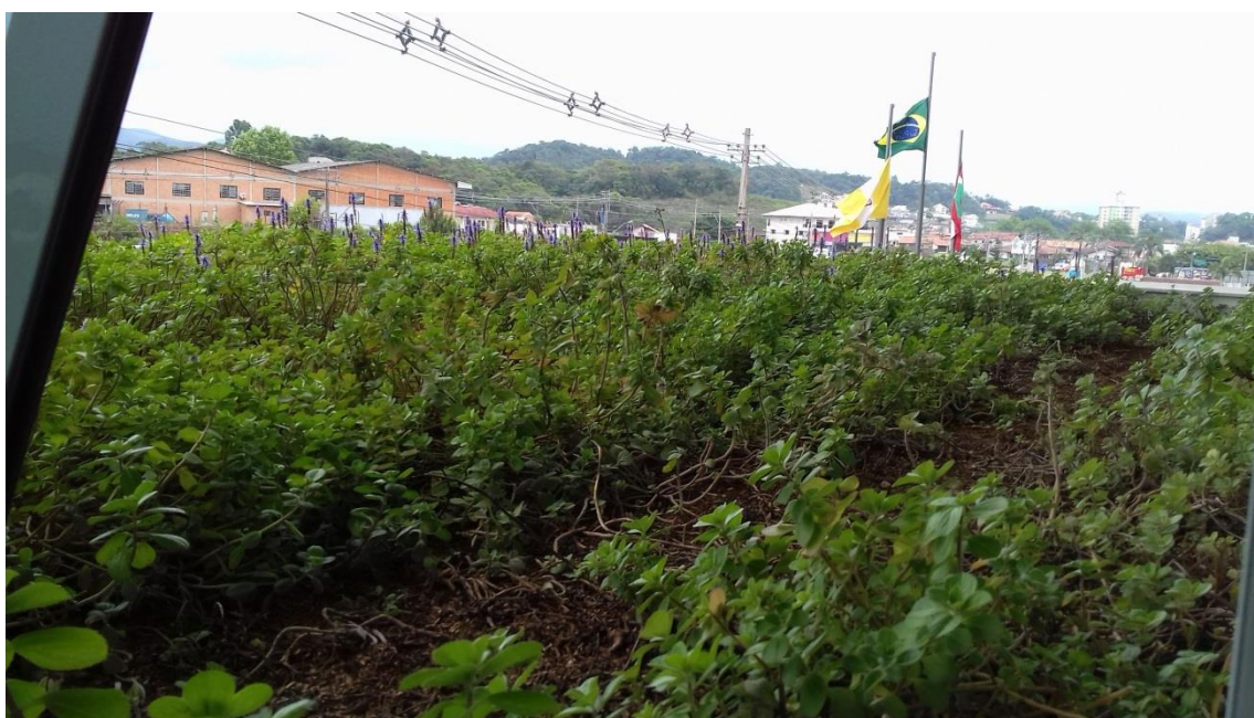
Figura 05: Cobertura verde do novo Fórum de Gaspar
