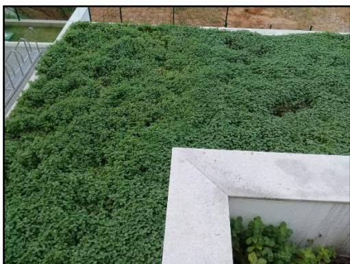
Figura 4 Cobertura verde – Foto: DFISC Julho/2018
