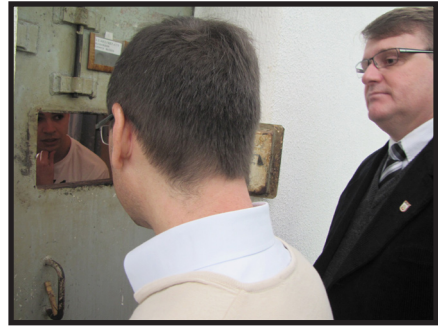
Durante vistoria no Complexo Penitenciário da Agrônômica, juízes detectaram muitos problemas que merecem atenção
